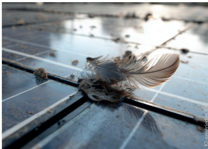
Schmutz führt langfristig zu Modulschäden
