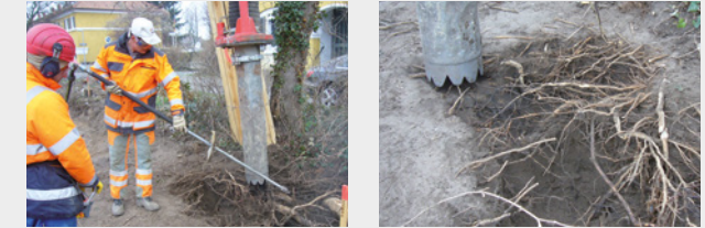
Wurzel- oder Baumsanierungen werden im Straßenbau dann gemacht, wenn der Baum erhalten bleiben soll
