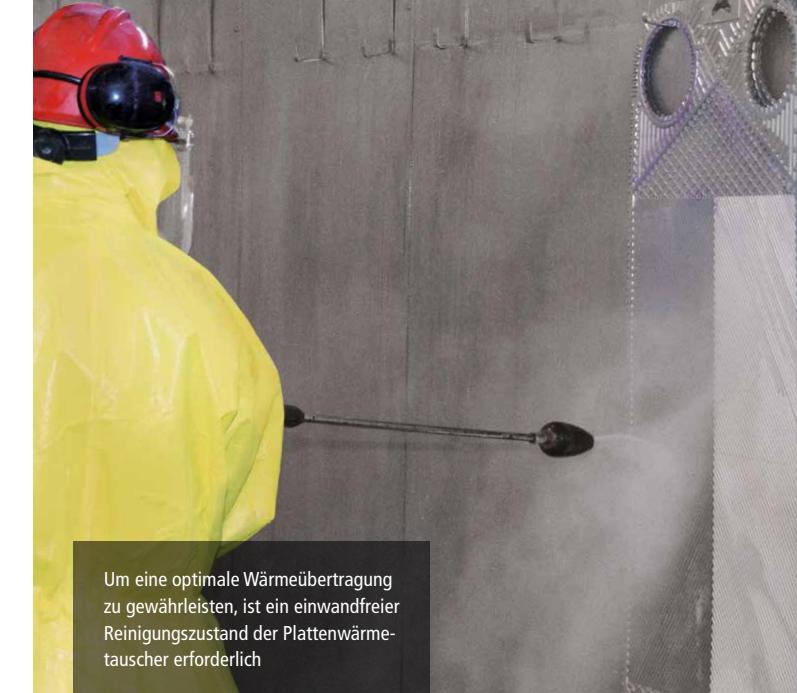
Um eine optimale Wärmeübertragung zu gewährleisten, ist ein einwandfreier Reinigungszustand der Plattenwärmetauscher erforderlich
